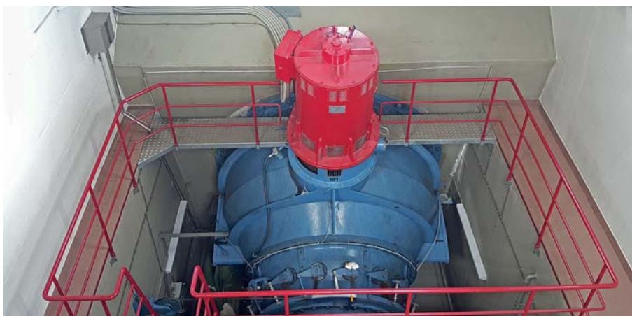
Bild 1. Beispiel einer Turbine-Generator-Komposition eines Kleinwasserkraftwerks.
